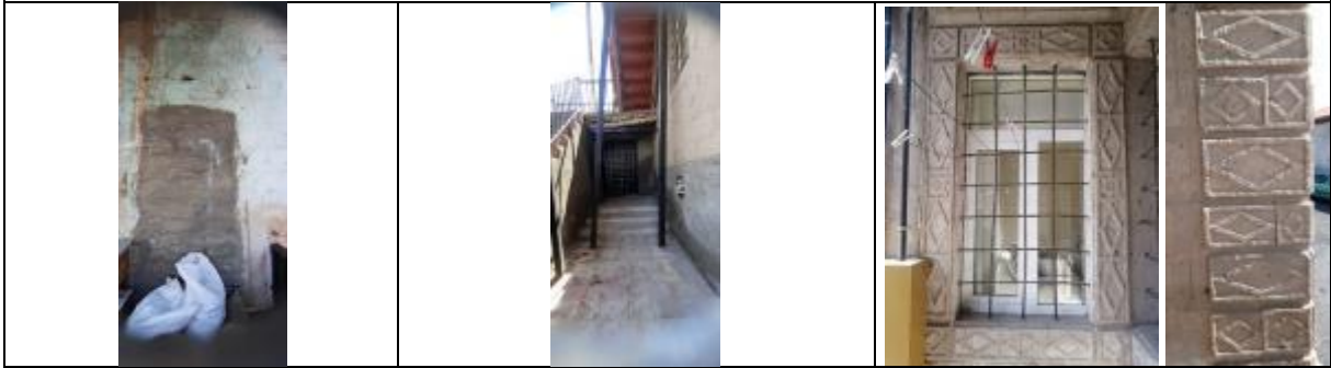
Şekil 12: a. Doğu Cephesinde Kapatılan Kapı b. Bahçeye Açılan Giriş Kapısı ile Birinci Kata Çıkan Merdiven İlişkisi c. Güney Cephesi Pencere Bezemesi ve Köşe Taşı Detayı (Kader Zor, Esra Çelik: 2023)
