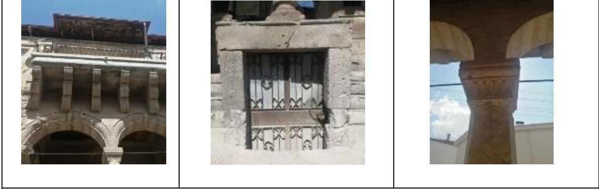
Şekil 11: a. Güney Cephesi Balkon Konsolları ve Bezemeleri b. Güney Cephesindeki Bodrum Kata İnen Kapı c. Güney Cephesindeki Sütun Detayı (Kader Zor, Esra Çelik: 2023)
