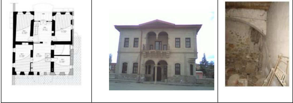
Şekil 1: a. Zemin Kat Planı Örneği (Karadayı Yenice, 2012: 31) b. Genel Cephe Özellikleri (Karadayı Yenice, 2012: 29) c. Genel Yapım Sistemi, Moloz ve Taş Malzemelerin Kullanımı (Karadayı Yenice, 2012: 41)
